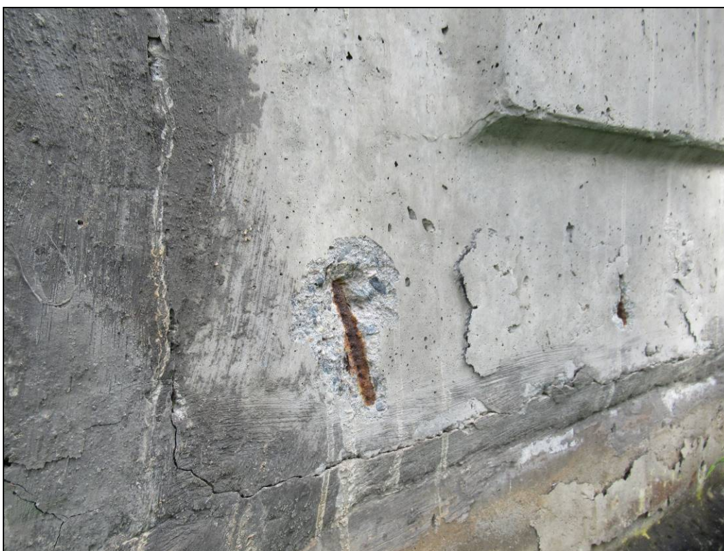
Obr. č. 5 - opady betonu v líci prefabrikovaných dílců, v místech opadů odhalena výztuž, která je napadena hloubkovou korozí
