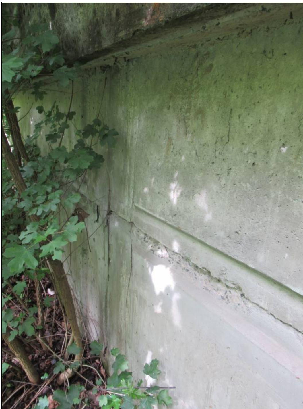
Obr. č. 7 – pohled na opěrnou zeď zprava (drolení betonu na styku dílců)
